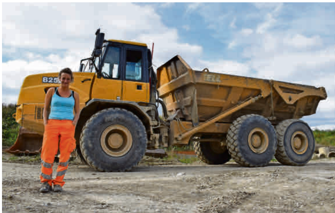
Die 25-jährige Annelies Schwizer auf der Baustelle Hegmatten. Hinter ihr der Dumper, den sie täglich durch die Gegend fährt. Bild: Talina Steinmetz
