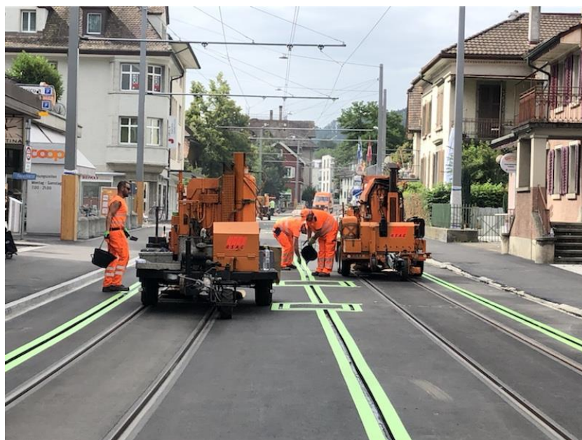
Schichtweiser Einbau Fuge
