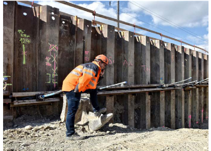
Technische Bauleitung in der Ausführungsphase Begleitung, Überwachung und Qualitätskontrollen
